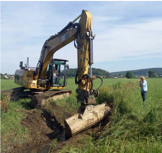
Aufweitung der Uferböschung durch Anlage von Bermen
