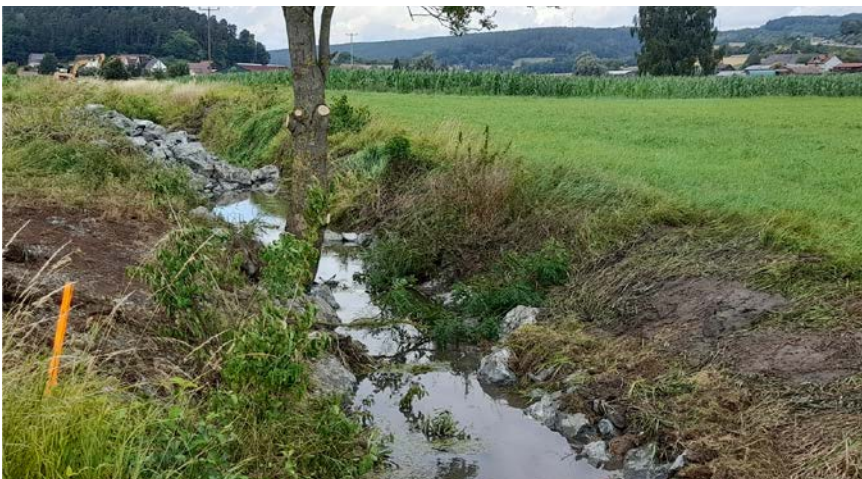
Abflussdynamik verbessert durch Störsteine, Modellierung Bachsohle
